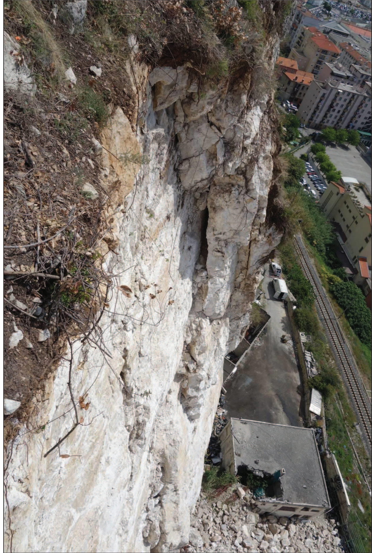
Vue de l'écaille fortement fracturée à miner depuis le surplomb - 06.05.2014
